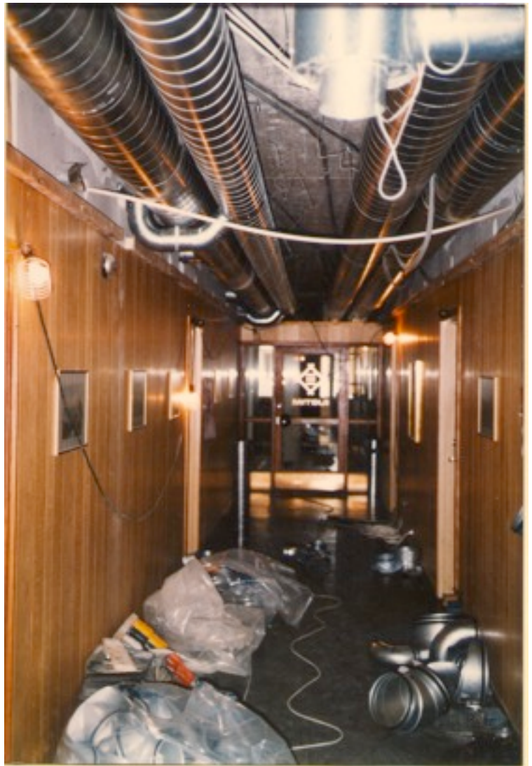
Nye ventilasjonskanaler i alle korridorhimlinger
