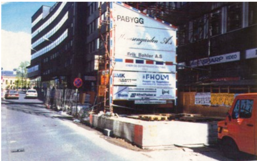
Fra byggingen av 9. etasje i 1988
